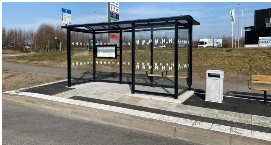
Hållplats Vrångagatan, Varbergs kommun
