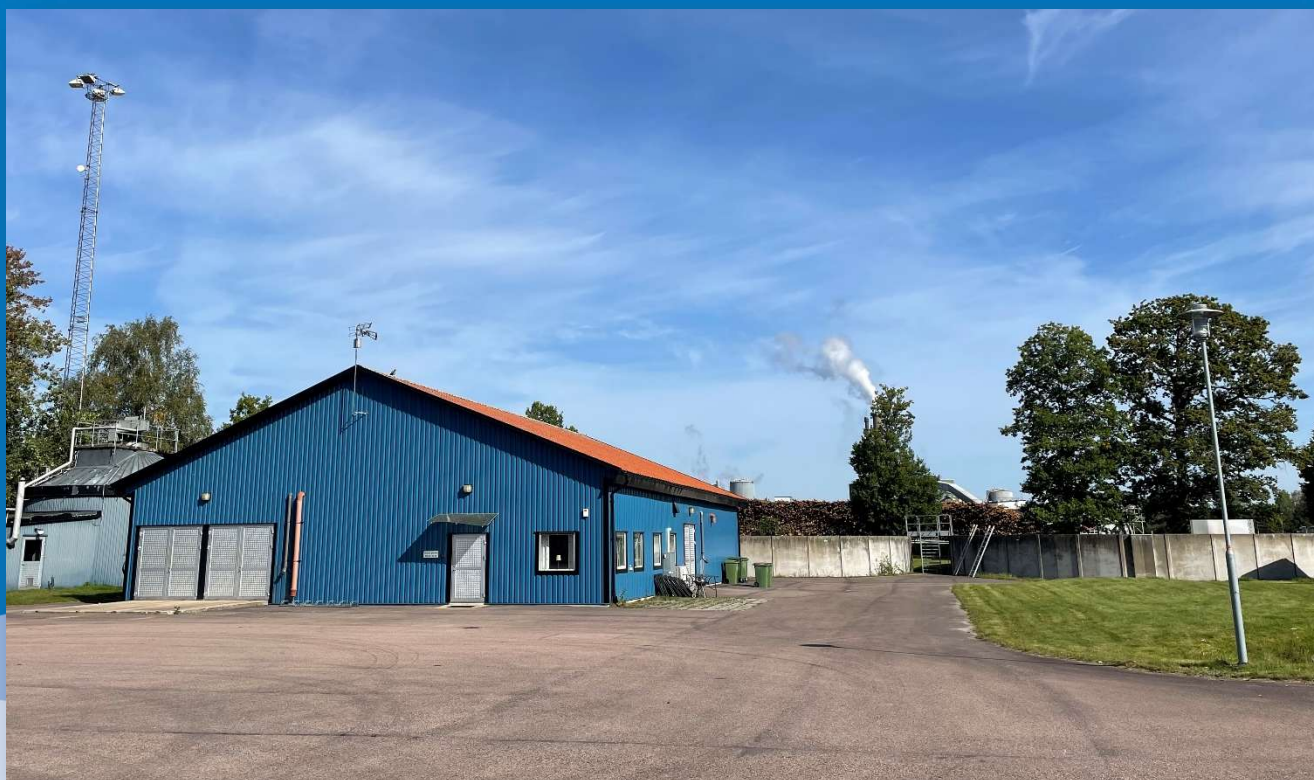
Hyltebruks avloppsreningsverk. Foto: Isac Lagerkvist
