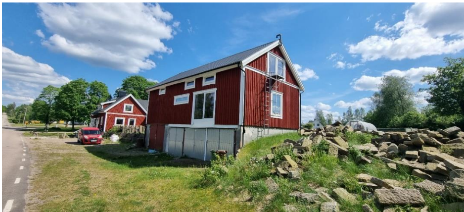
Befintlig huvudbyggnad på platsen, 2024-05-22.
