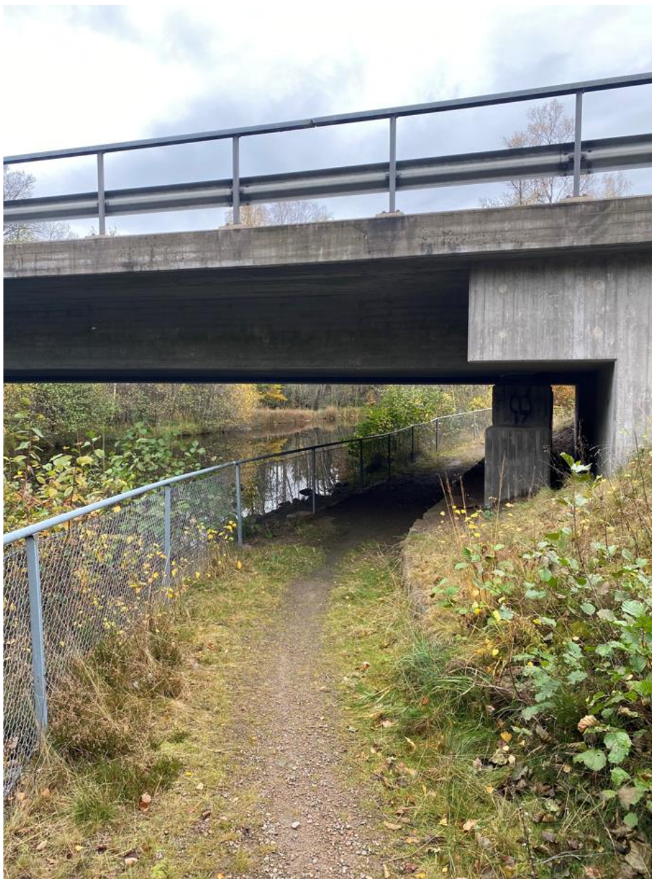
Gång- och cykelväg som löper längst planområdet och vidare in under väg 26.
