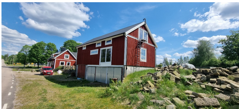
Befintlig huvudbyggnad på platsen, 2024-05-22.
