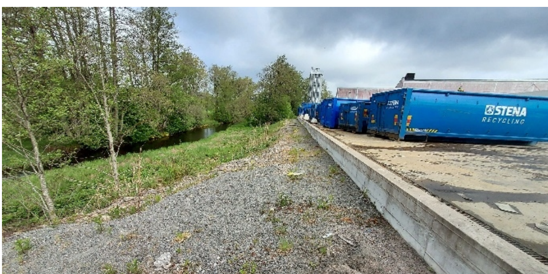
Foton över berört område i relation till Österån. Översta bilden visar högt vattenstånd i januari 2024, nedre visar normalt vattenstånd maj 2023. Foto: Jan Lundsten, Frauenthal Gnotec Sweden AB, Sayle Shamun, C3S Miljöteknik.
