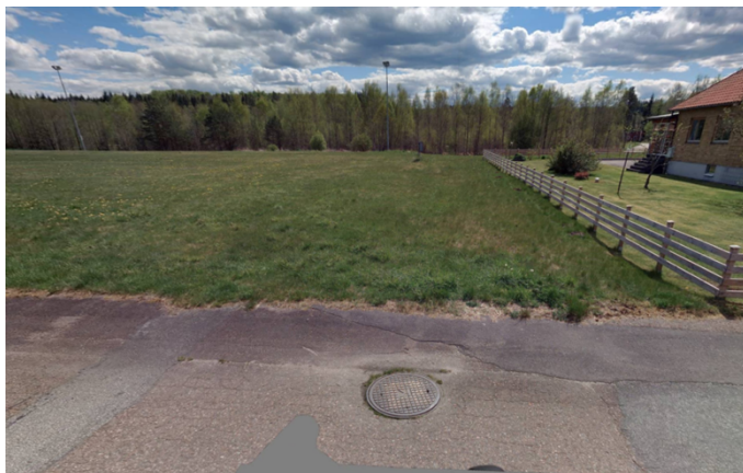
Fr Movägen och söderut, DV-ledning längs staketet
