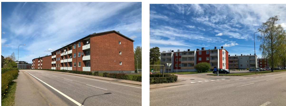
Figur 7 och 8. Bostadsbebyggelse längs med Norra Industrigatan, väster (t.v.) respektive öster (t.h.) om Porsgränd.
