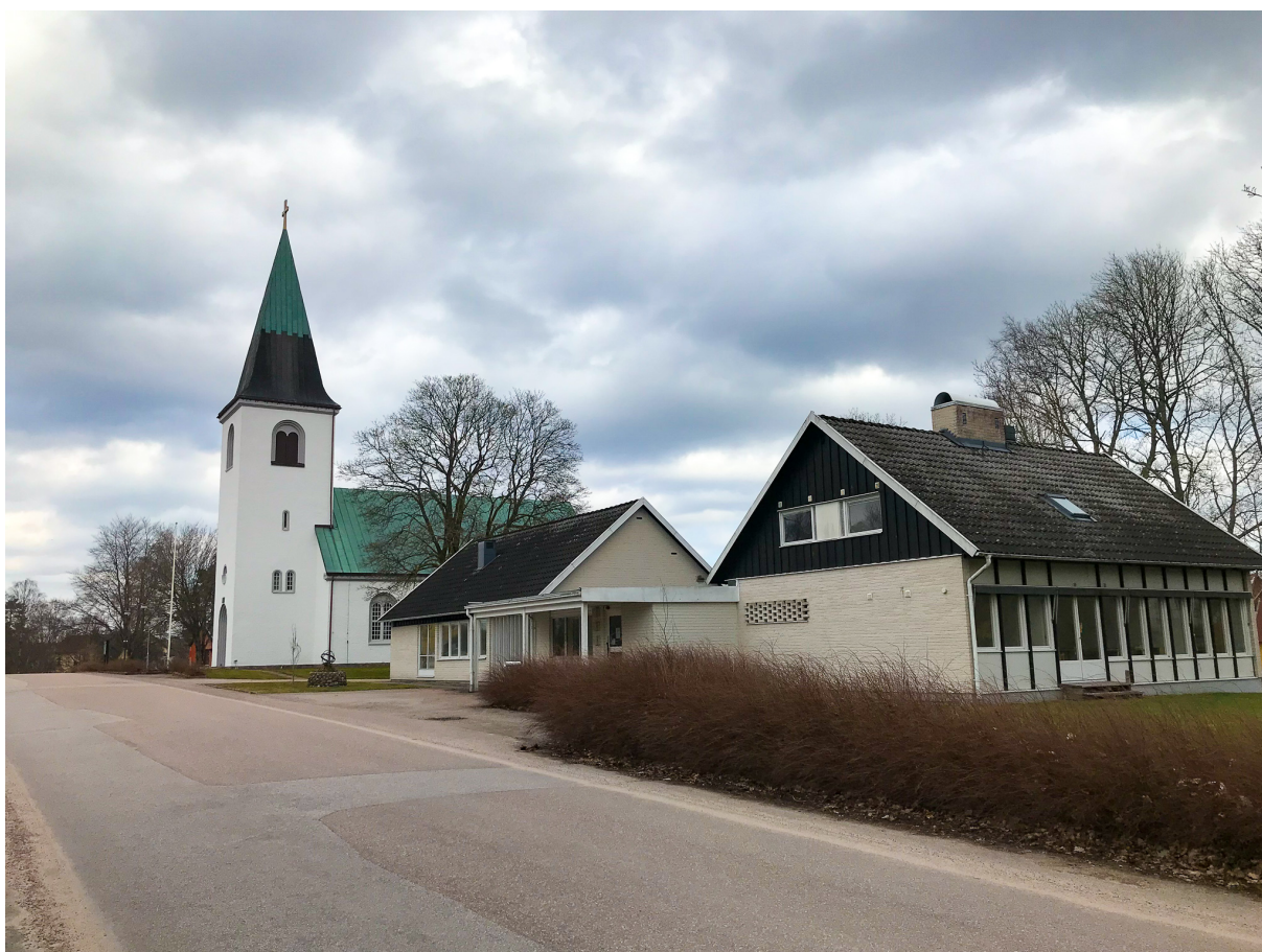
Befintlig byggnad på fastigheten Västra Hylte 3:13 med kyrkan i bakgrunden.
