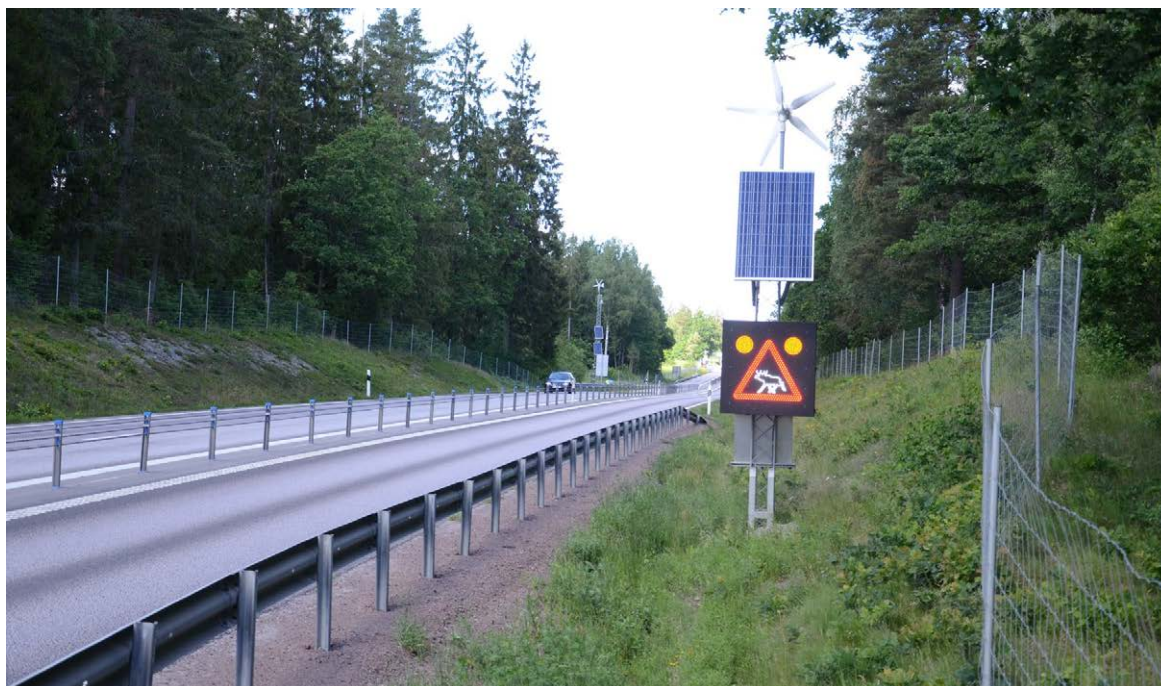
Figur 24. Vid en faunapassage i plan varnas trafikanterna med en variabel meddelandeskylt som tänds upp när djur befinner sig i faunapassagen. Skylten sätts cirka 100–150 meter från faunapassagen.
