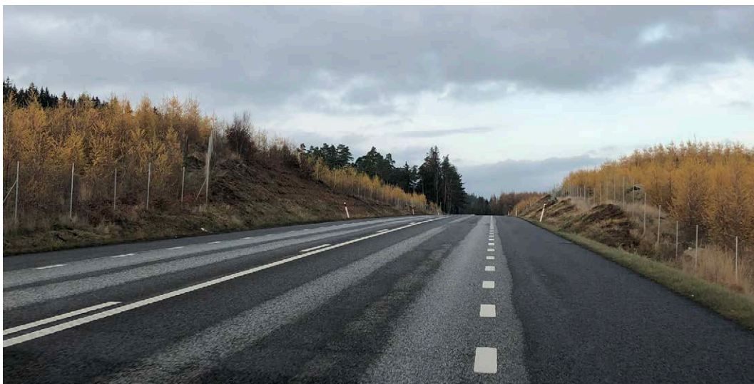
Figur 34. Läge 102, Moaslätten, föreslagen plats för en faunabro. Notera höjdstöd i terrängen på både sidor och ett omkringliggande skogslandskap. Foto mot söder. Foto: Henrik Wahlman.
