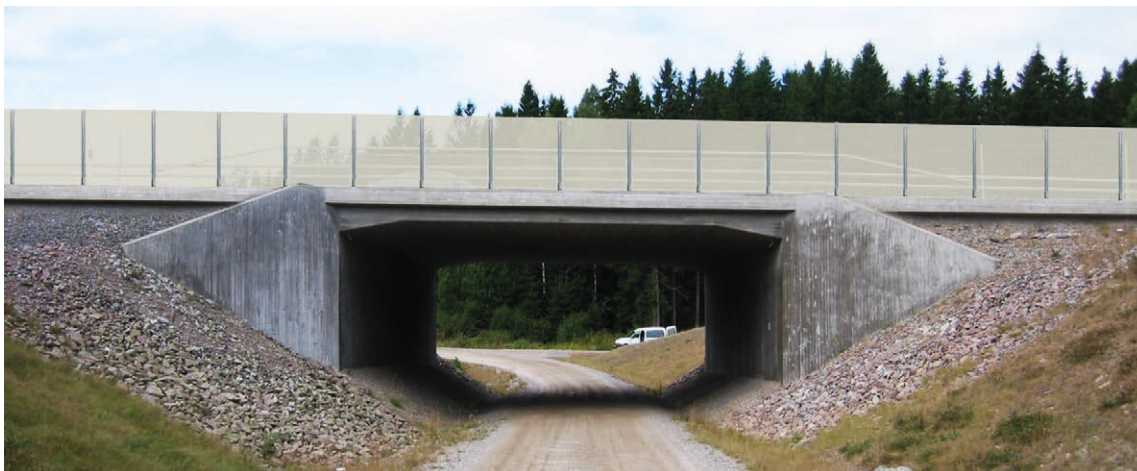
Figur 17. Illustration av siktskärm på befintlig port. Siktskärmen skall dock inte vara transparent som i denna illustration. Detaljutformning av siktskärm tas fram i kommande skede, och behöver utgå från de förutsättningar som varje bro medger. Illustration: EnviroPlanning.
