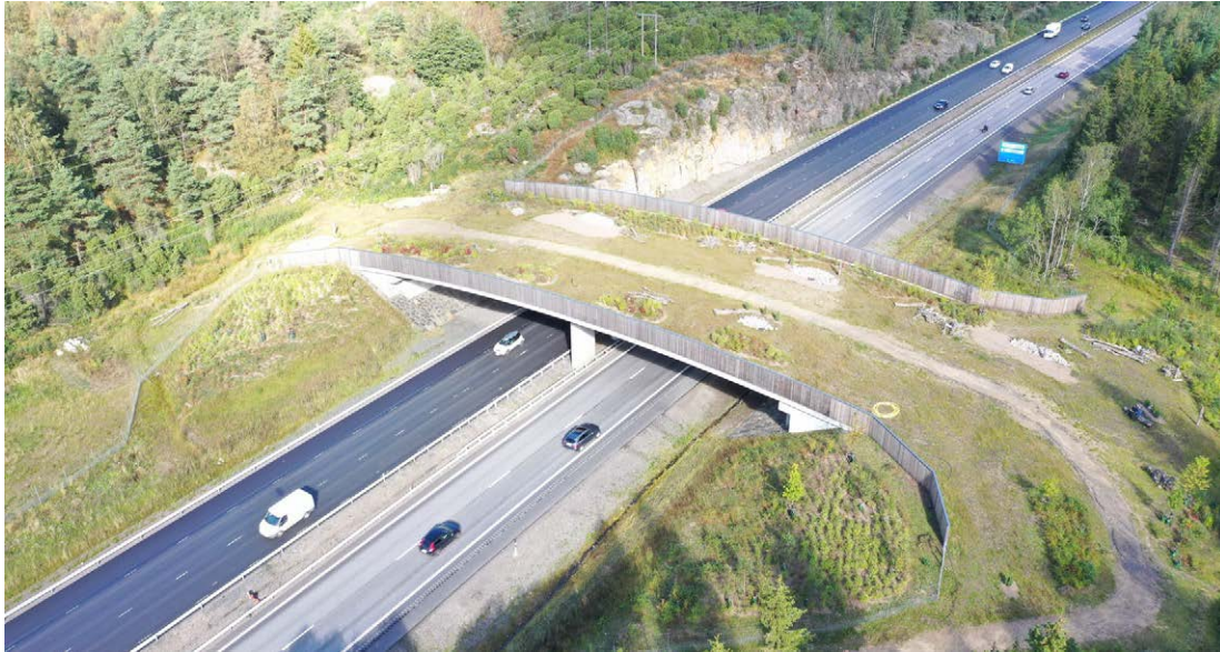
Figur 45. Ekodukt Sandsjöbacka är ett exempel på hur en ekodukt kan visuellt anpassas till omkringliggande landskap. På bilden kan man se hur faunaskärm och kantbalk smälter samman och ansluter till landskapet. Foto: EnviroPlanning, Fredrik Winterås
