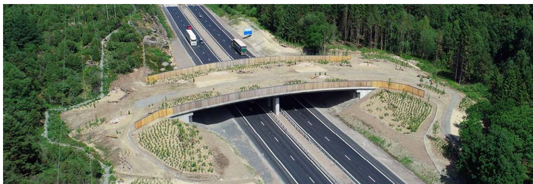
Figur 35. Ur gestaltningssynpunkt är det viktigt att faunaskärmen ansluter väl till landskapet och att den inte upplevs för hög ur trafikantsynpunkt. Foto från Ekodukt Sandsjöbacka
