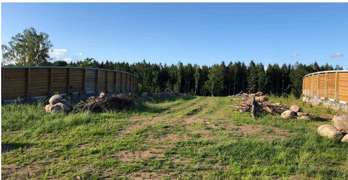
Figur 3. Faunabro utmed väg 21 söder om Hässleholm. Bron har en bredd på cirka 20 m. Foto: EnviroPlanning, Mattias Olsson 2020.
