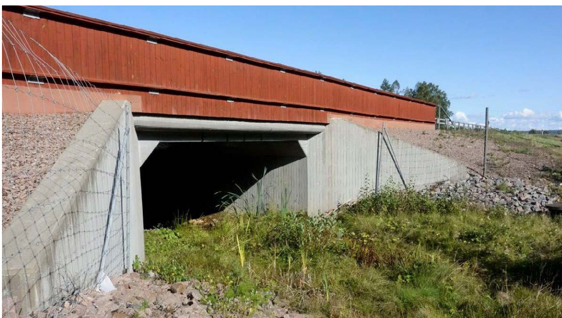
Figur 18. Bild på en skärm på befintlig bro vid väg 49 Skara-Axvall. Bilden visar på principen med skärm och att kunna skydda faunan från de störningar som finns på vägen. Detaljutformning på de skärmar som föreslås i detta projekt tas fram i kommande skeden. Foto: Mattias Olsson 2020.
