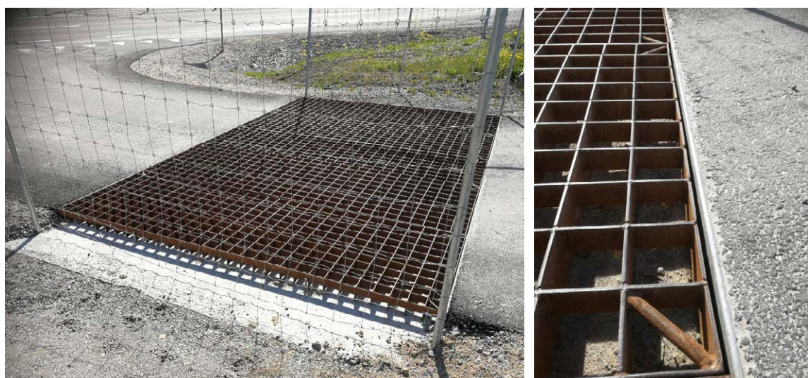
Figur 15. Färister i så kallad durkmodell på en anslutande väg vid väg 23/34 söder om Linköping. Foto: Henrik Wahlman, EnviroPlanning.
