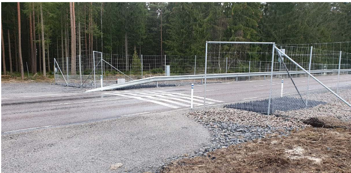
Figur 23. Detaljbild från faunapassage i plan på väg 42, notera hur viltstängsel ansluter tätt till vägbanan för att förhindra djur att ta sig innanför viltstängsel. På vägbanan finns målade linjer för att trafikanten skall kunna identifiera när man åker in i faunapassagen. Dessa målade linjer kan även fungera som ledlinjer för viltet och minska risken att de vandrar in mellan viltstängslen. Foto: EnviroPlanning, Fredrik Winterås.
