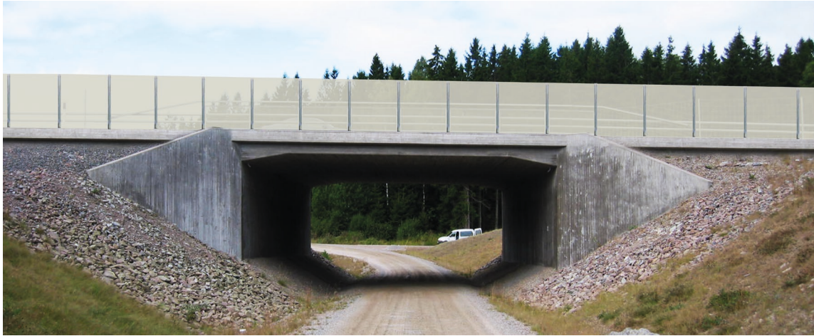
Figur 17. Illustration av tänkbar lösning med siktskärm på befintlig port. Siktskärmen skall dock inte vara transparent som i denna illustration. Illustration: EnviroPlanning.
