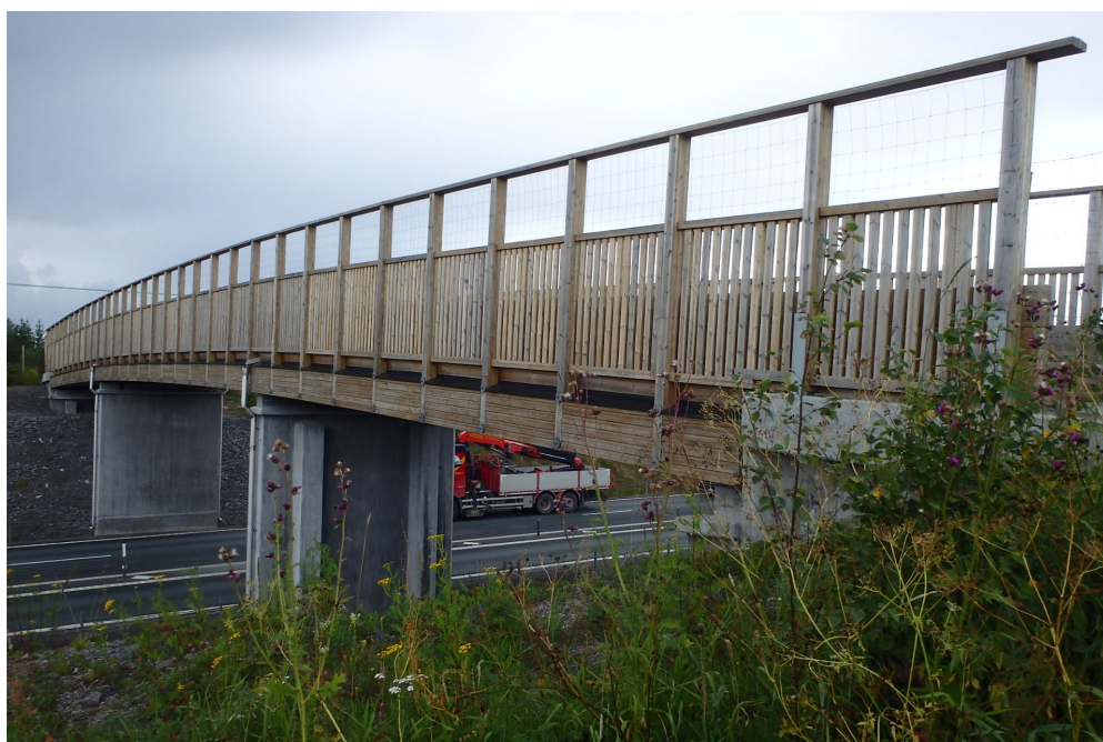
Figur 39. Ren- och faunabro i trä över E4 Harrioja. Faunaskärmen på denna bro är anpassad för renar, som vill ha översikt i landskapet när de passerar. Denna typ av faunaskärm är ej aktuell i detta projekt. Foto: BaTMan.
