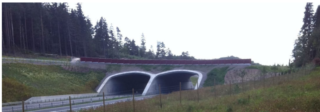
Figur 40. Valvbågar i betong och plåt på E45 norr om Lilla Edet.
