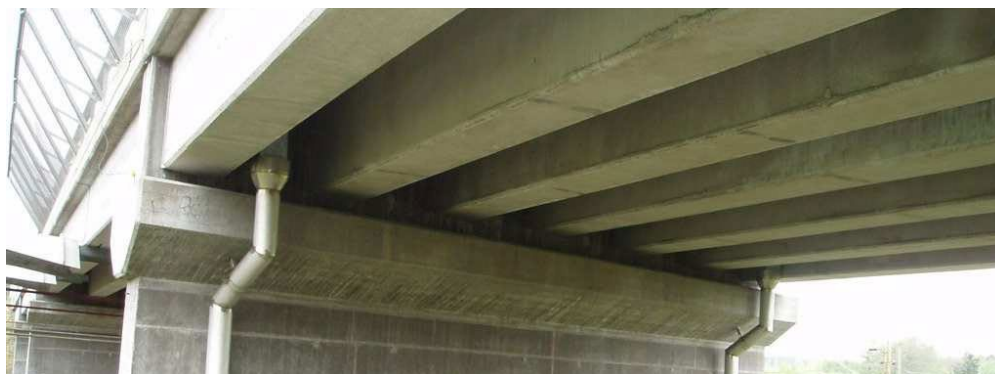
Figur 41. Bro med prefabricerade betongbalkar över järnväg norr om Osby. Foto från BaTMan
