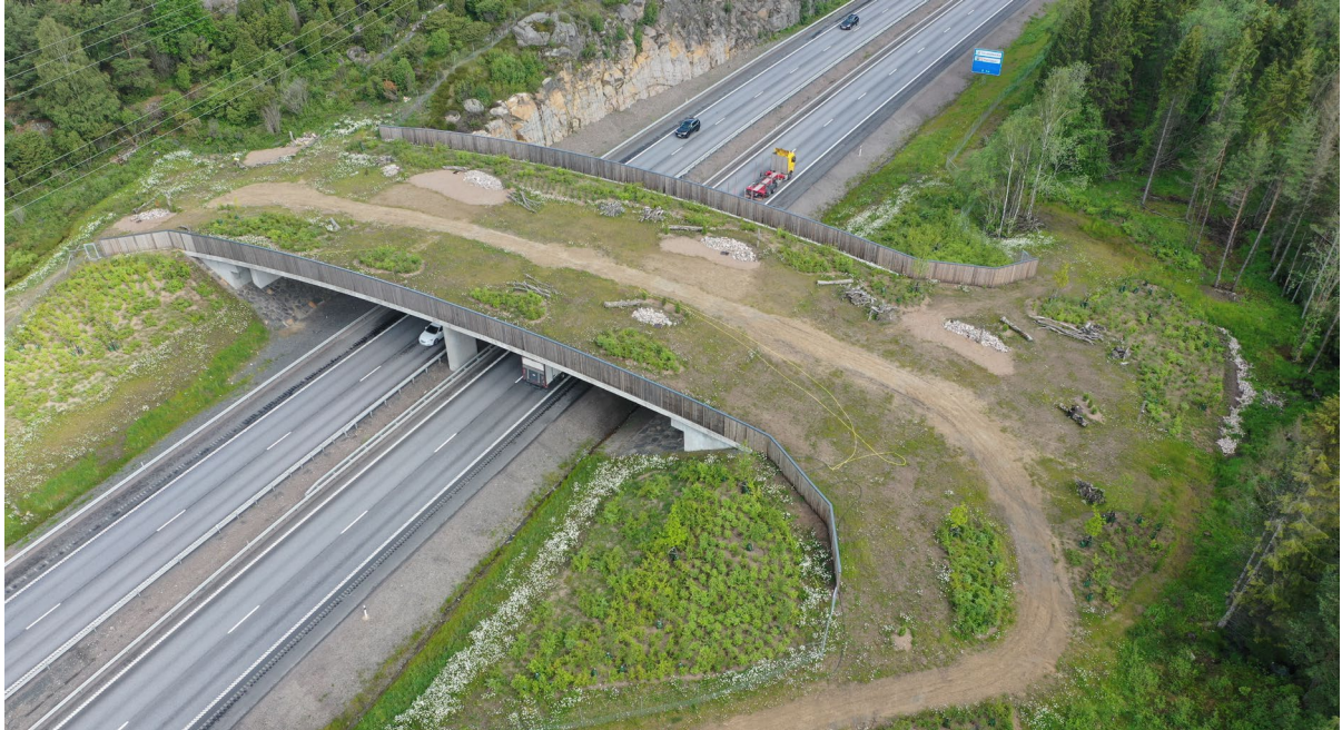
Figur 2. Ekodukt Sandsjöbacka. En bred (32 m) och lång (64 m) bro med flertalet strukturer som död ved, stenrösen och planterade buskage på bron som skapar biotoper för ett brett spektrum av djur. Stor vikt har lagts på rätt jordmån och växtlighet på ekodukten. Foto: EnviroPlanning, Fredrik Winterås 2019
