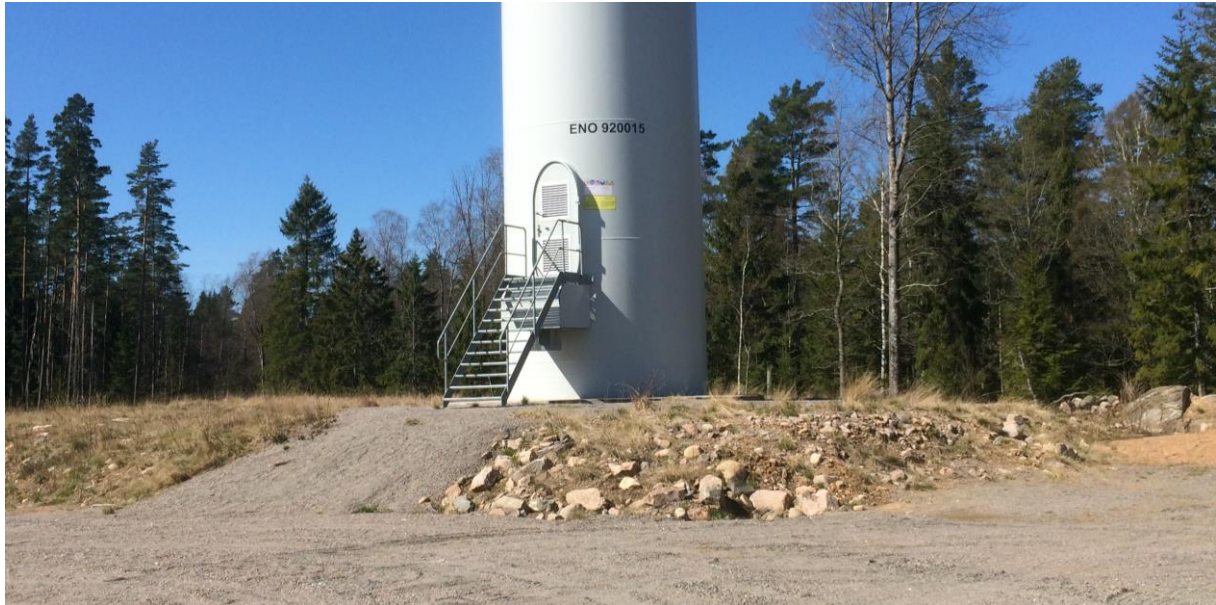
Figur 12. Exempel på hur ett gravitationsfundament kan se ut efter färdig byggnation.
