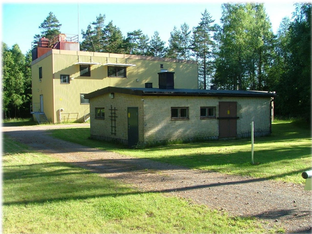
Jansbergs Vattenverk, Hyltebruk
