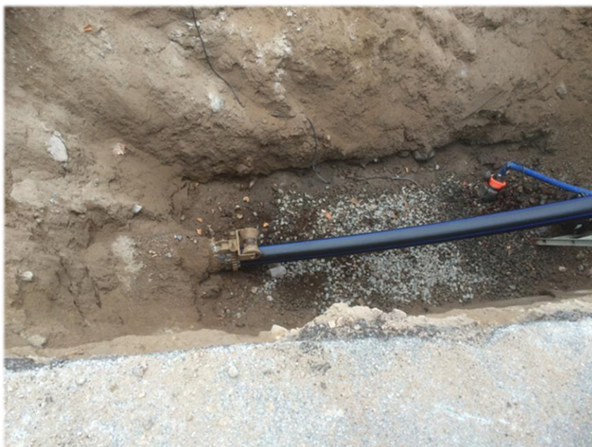
Reliningsarbeten dricksvattenledning, Hyltebruk
