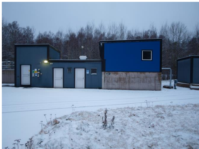
Torups reningsverk, luftningsbassänger överbyggnad
