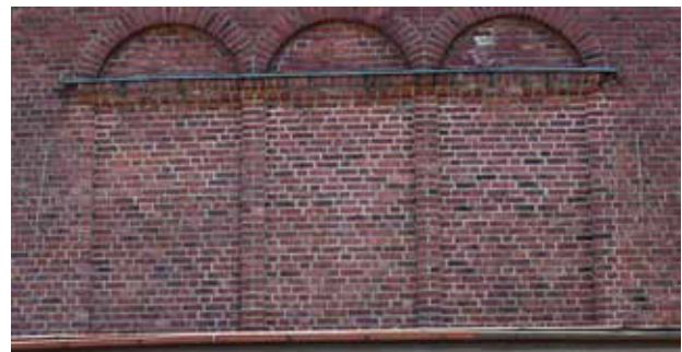
Fasaddekor i tegel. De övre bågarna verkar ursprungligen varit putsade
