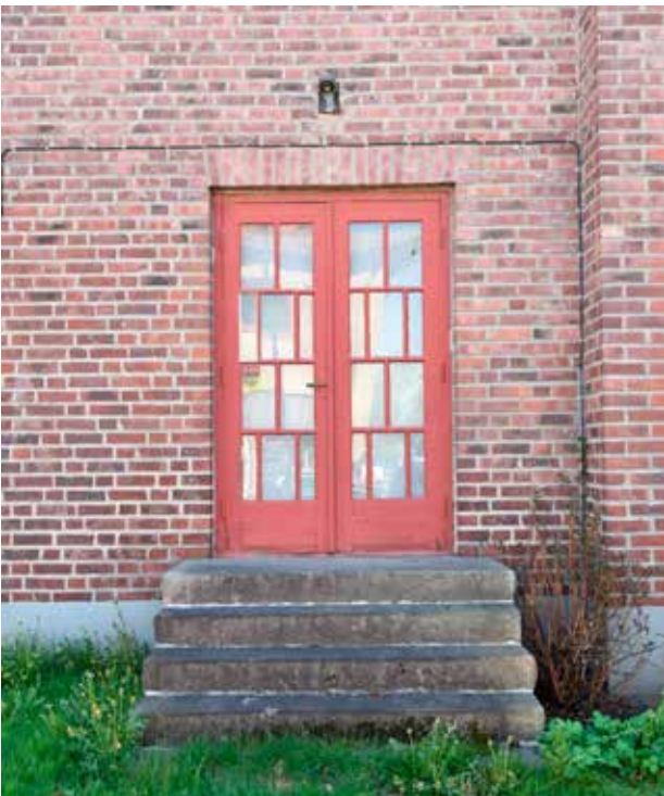
Ursprunglig uppglasad entrédörr av trä liksom gjuten trappa utan trappräcke
