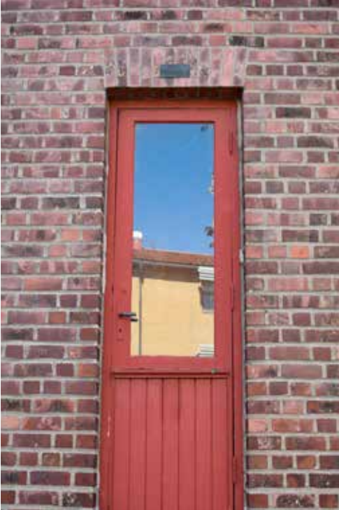
Ursprunglig entrédörr på nordvästra långsidan. Här syns även trappan med trappsteg av sten, liksom den vackra röda tegelfasaden
