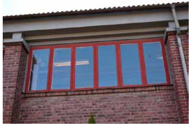
Ursprungliga träfönster längs gymnasiksalens övre del. Här skymtar även pilastrarna på ömse sidor om fönstren
