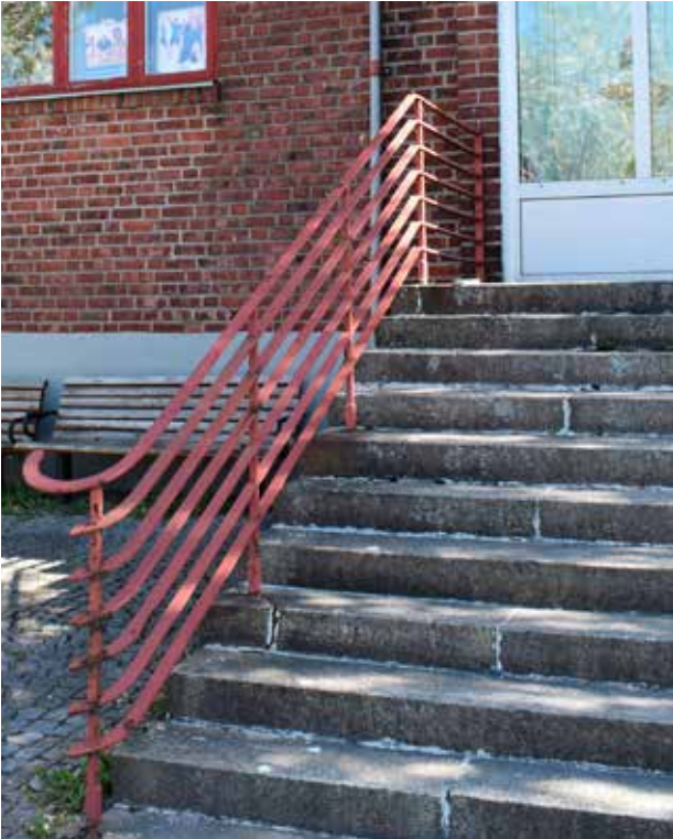
Ursprunglig stentrappa och trappräcke
