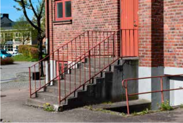
Exempel på ursprunglig gjuten trappa med trappa och trappräcke
