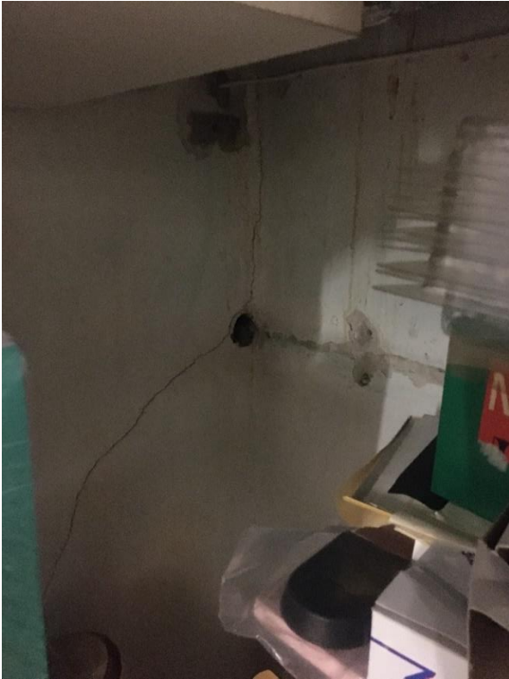
Bild 5: Del av källare i Lärosalsbyggnad.
