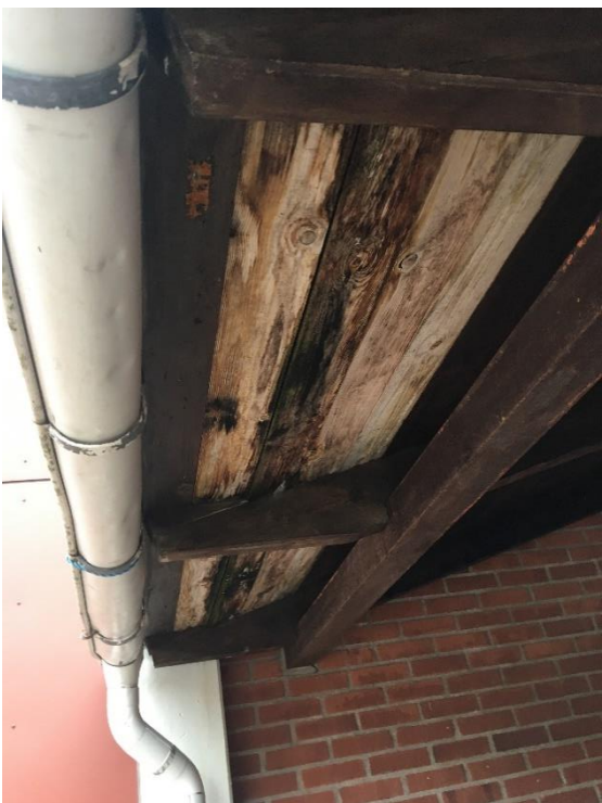
Bild 14: Regnskydds tak ovan ingång till omklädningsrum
