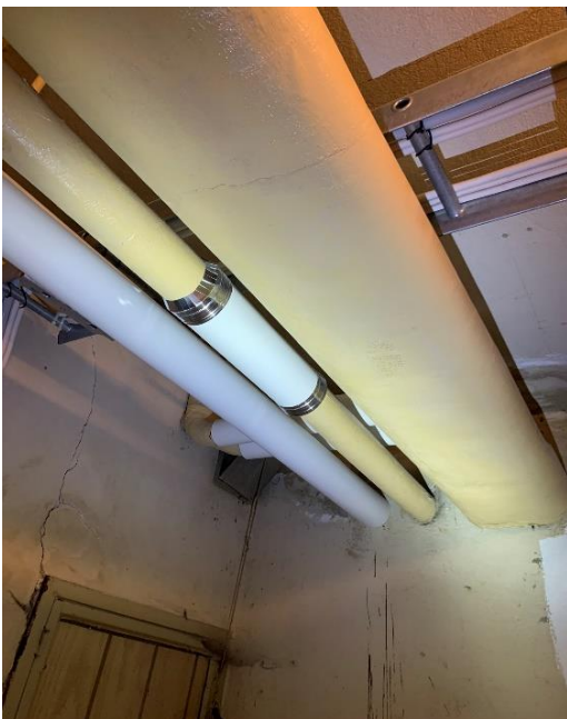
Bild 4: Del av källare i huvudbyggnad
