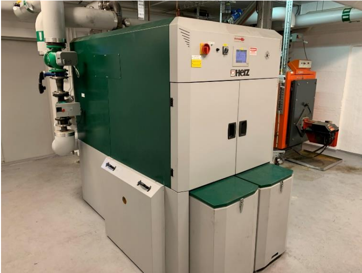
Bild 21: Pelletspanna undercentral
