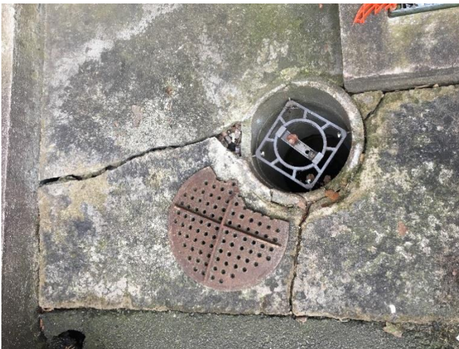
Bild 25: Dagavvattningsbrunn baksida skola
