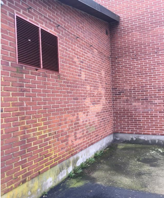
Bild 7: Vägghel i anslutning till omklädningsrumsdel.
