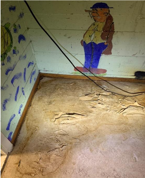
Bild 3: Del av källare i huvudbyggnad
