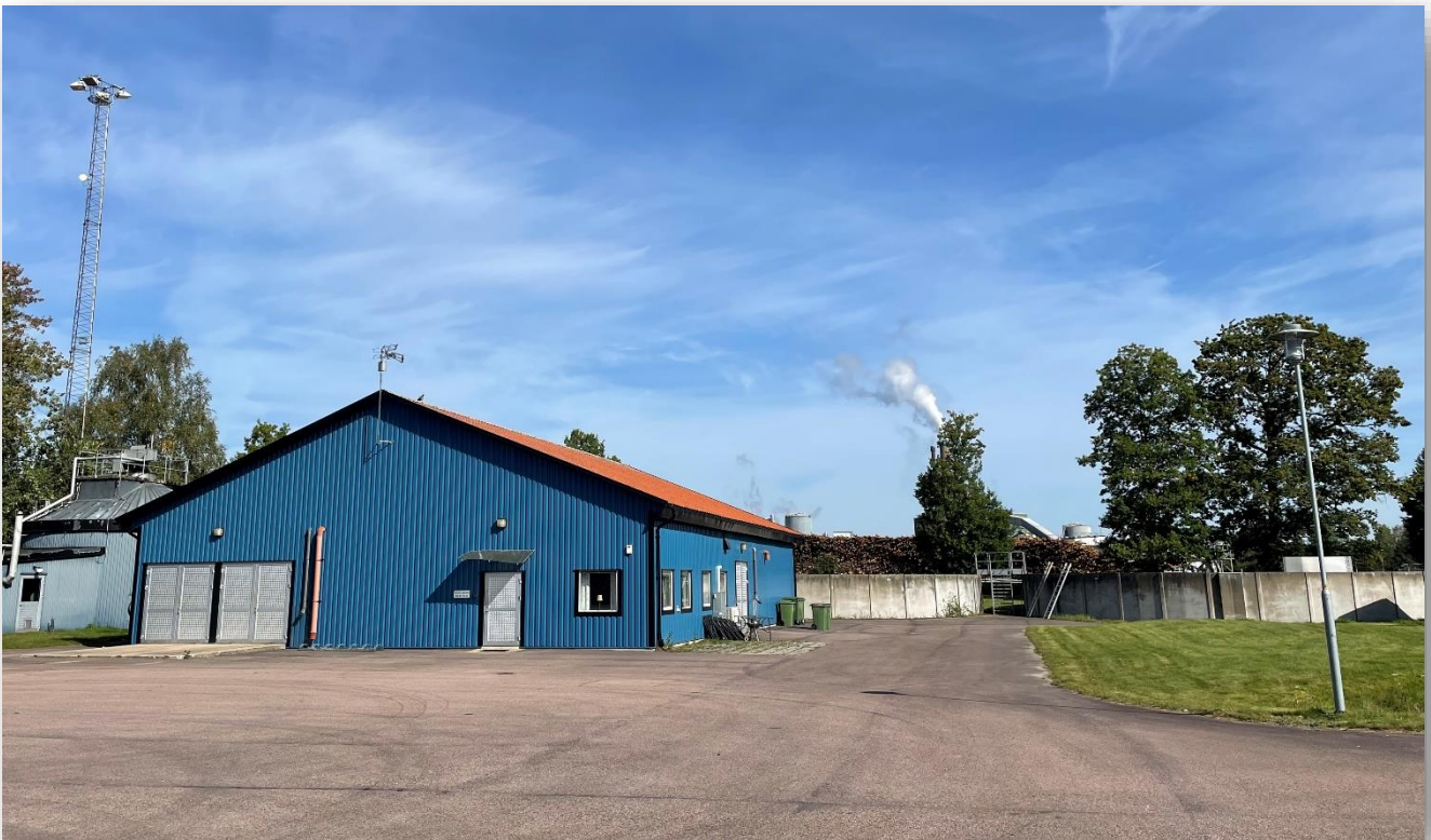
Hyltebruks avloppsreningsverk. Foto: Isac Lagerkvist
