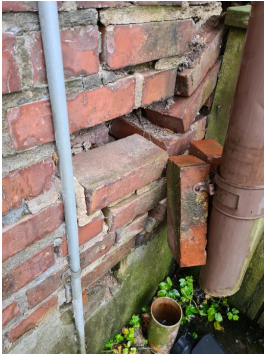
Bild 21, stuprör vid terrassbjälklag
