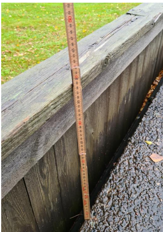
Bild 18, höjd räcke terrassbjälklag
