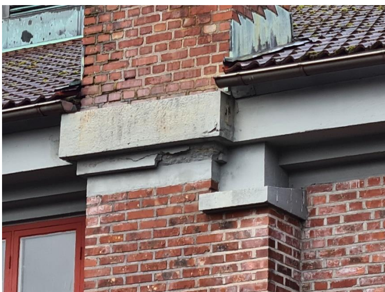
Bild 11, Skorsten, strävpelare/ kontrefort
