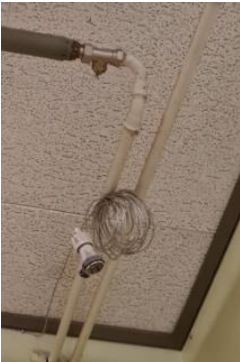
38, termostater takvärmare i Rc lokal
