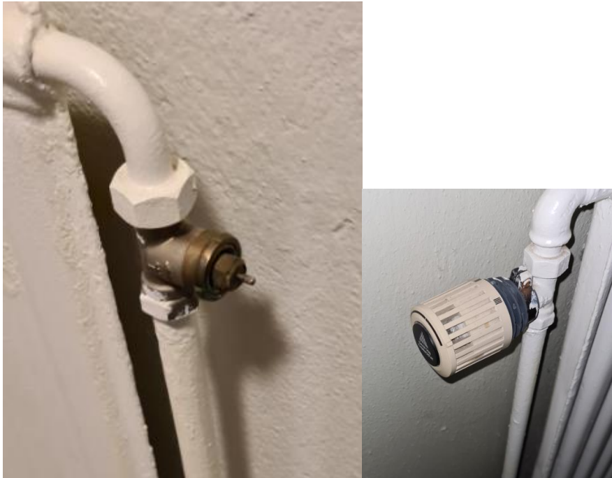
Bild 31, radiatorventil, termostat
