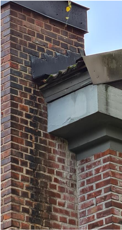
Bild 12, Skorsten, strävpelare/ kontrefort
