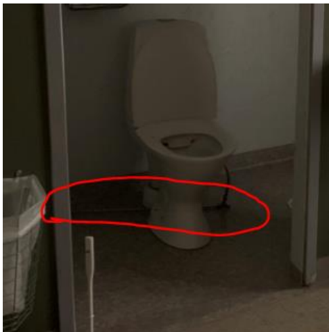
Bild 56. Toalett i tillbyggnad, omkl rum
