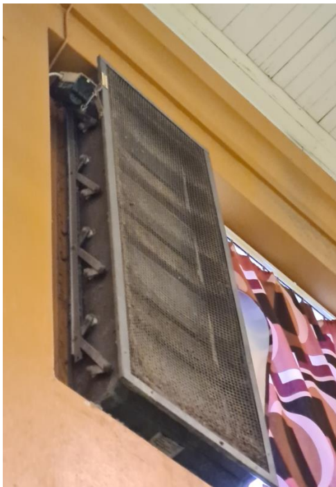
Bild 52, Tak i gymnastikhall
