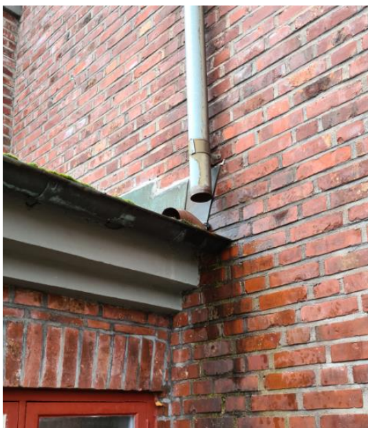
Bild 17, i innerhörn på terrassbjälklag
