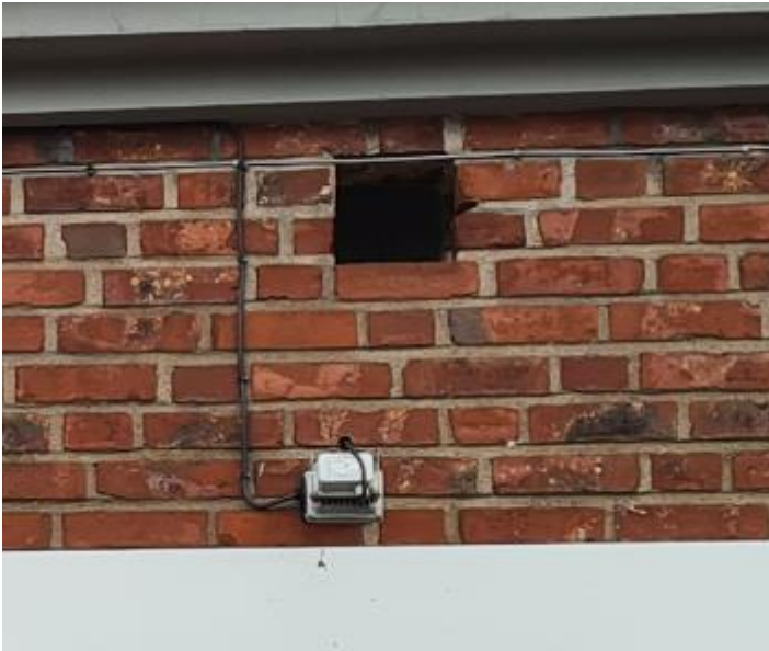
Bild 8, fasad på tillbyggnad.
