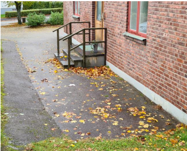
Bild 9, dörr på kortsida av tillbyggnad.
