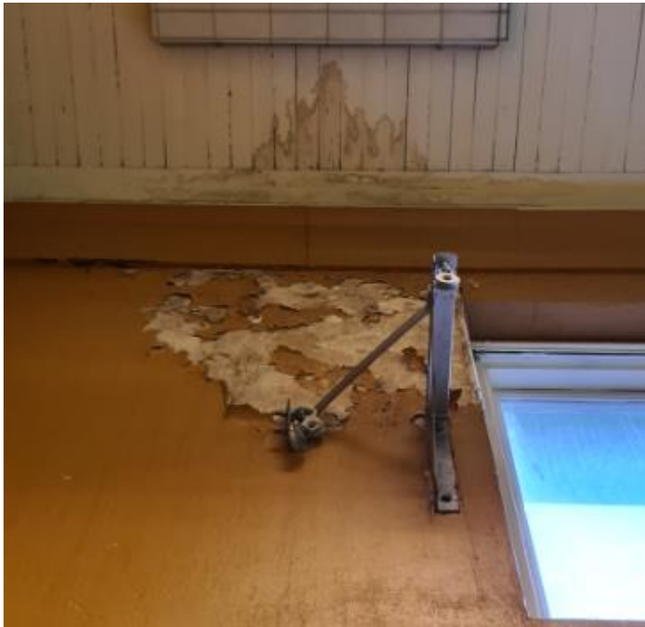
Bild 50, Tak i gymnastikhall
