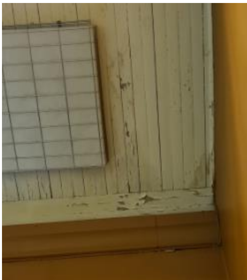
Bild 51, Tak i gymnastikhall
