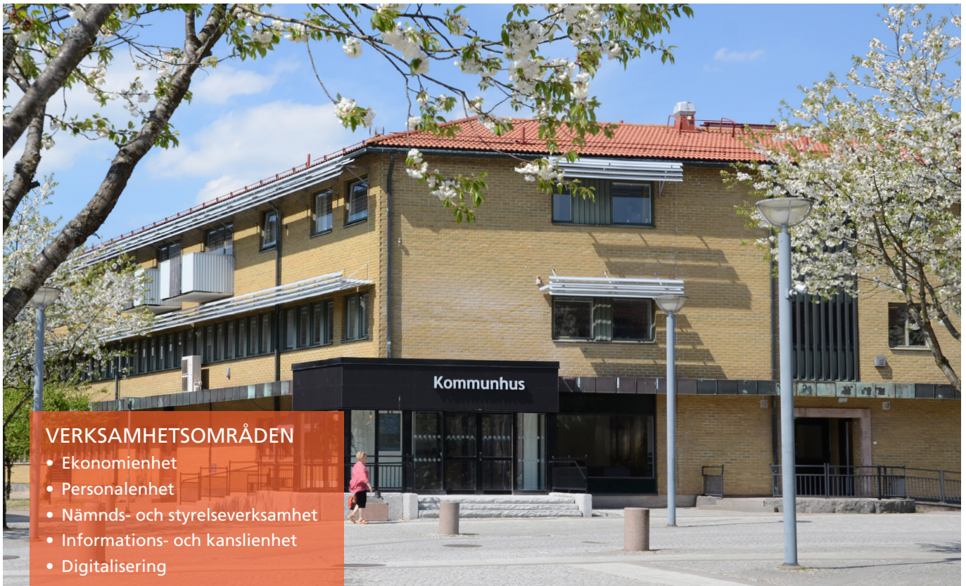
Kommunhuset i Hyltebruk.
