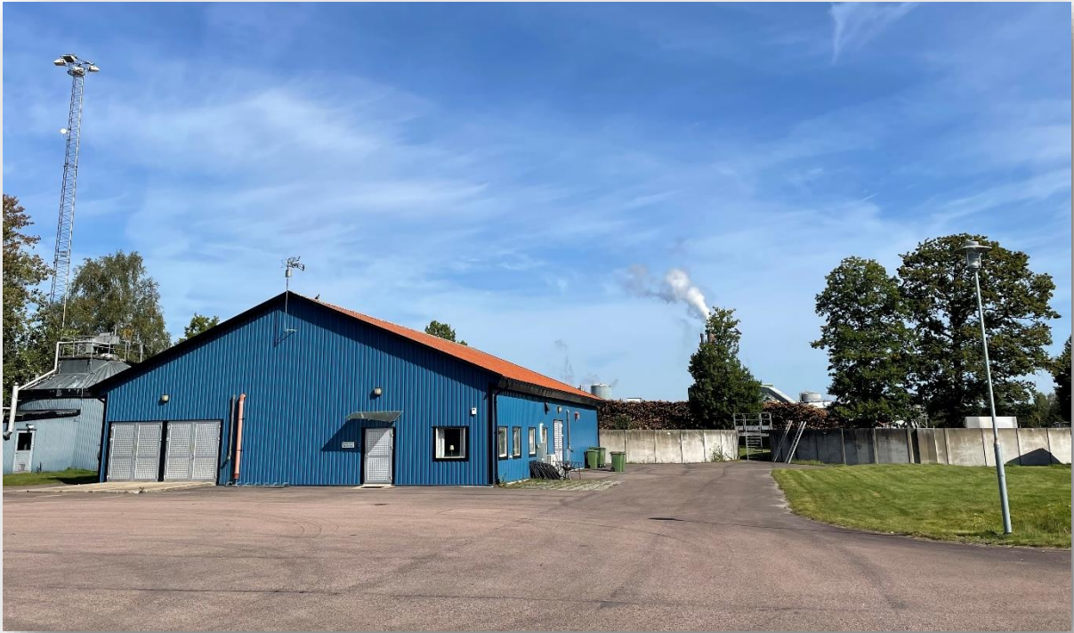
Hyltebruks avloppsreningsverk. Foto: Isac Lagerkvist
