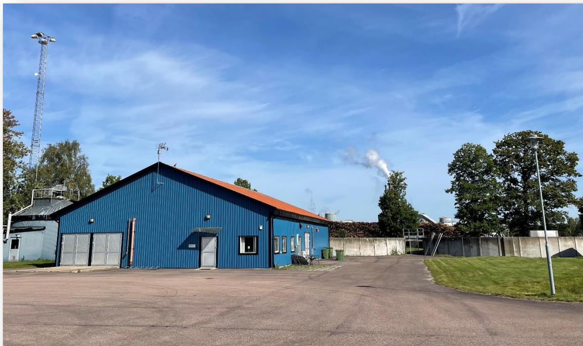
Hyltebruks avloppsreningsverk. Foto: Isac Lagerkvist
