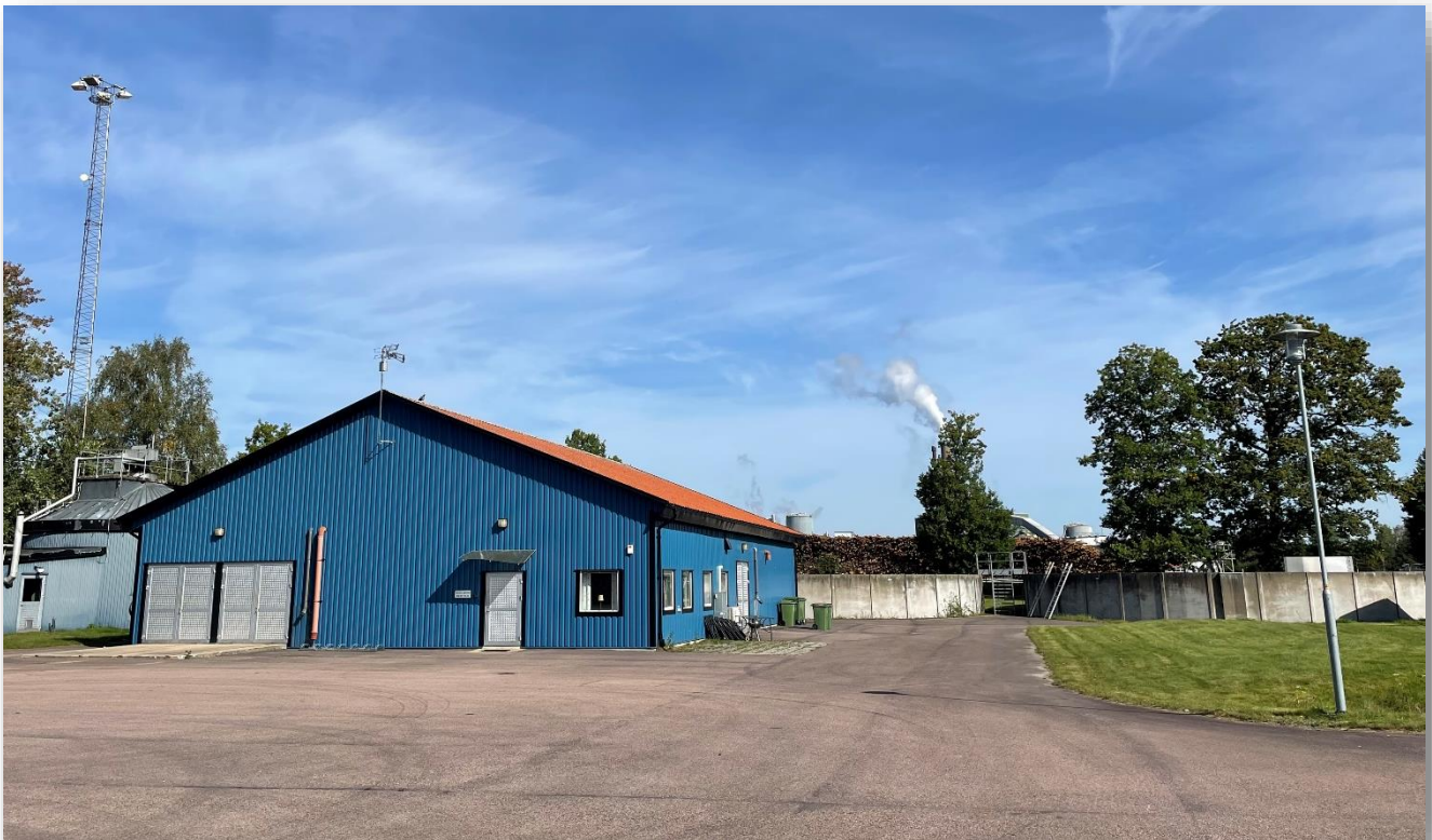
Hyltebruks avloppsreningsverk. Foto: Isac Lagerkvist
